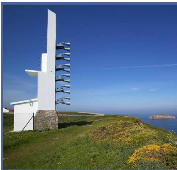
Sirena del faro de Cabo de Peñas de vibradores electromagnéticos
