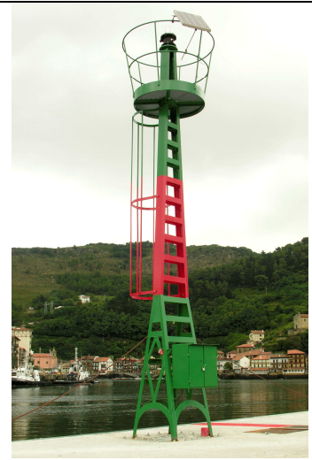
Marca Lateral modificada (canal principal a babor)
